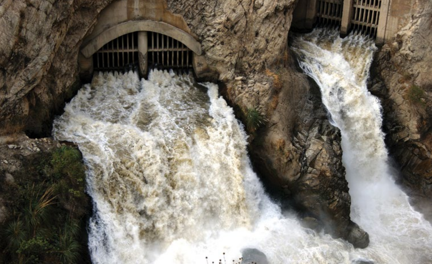
Imagen: central hidroeléctrica Cañón del Pato, cortesía de Duke Energy.
