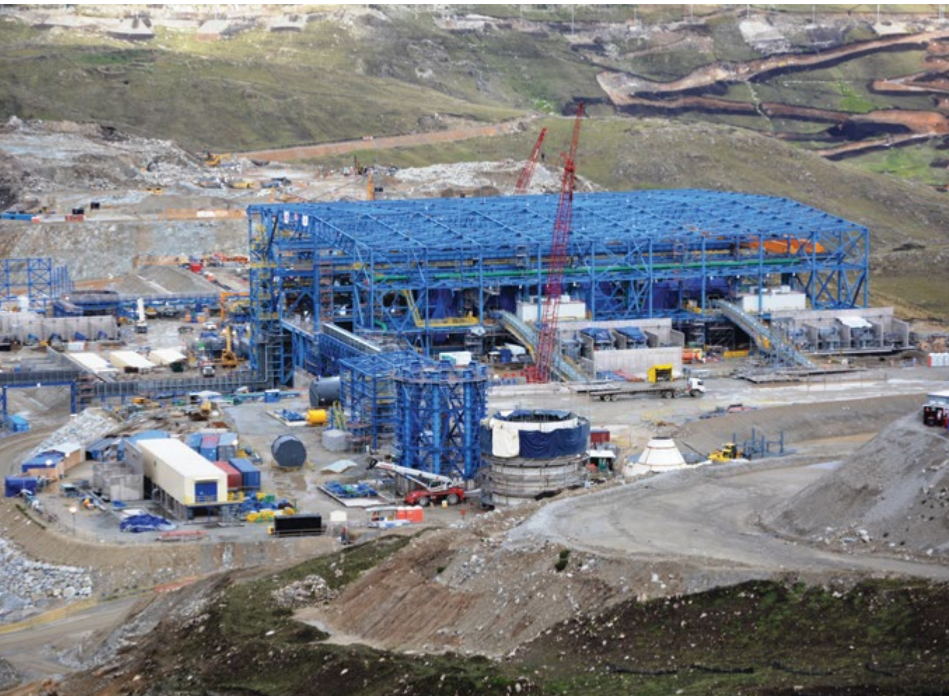
Imagen: Proceso de construcción de la planta concentradora de Las Bambas. Foto cortesía de MMG.
