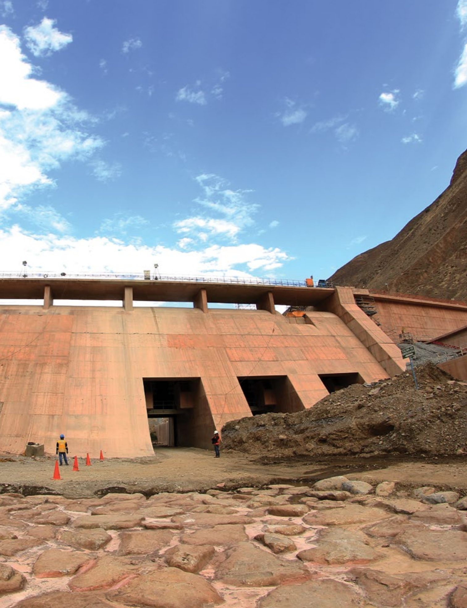
Imagen: Construcción de la central hidroeléctrica Cheves. Foto cortesía de ICCGSA.
