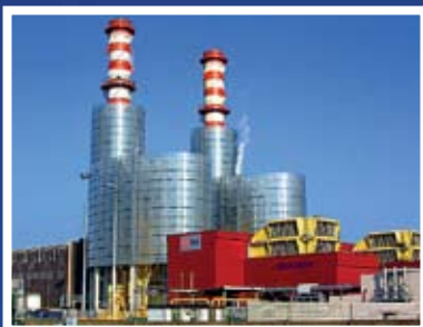
PORTO CORSINI, Italy, HRSG for Power Plant
