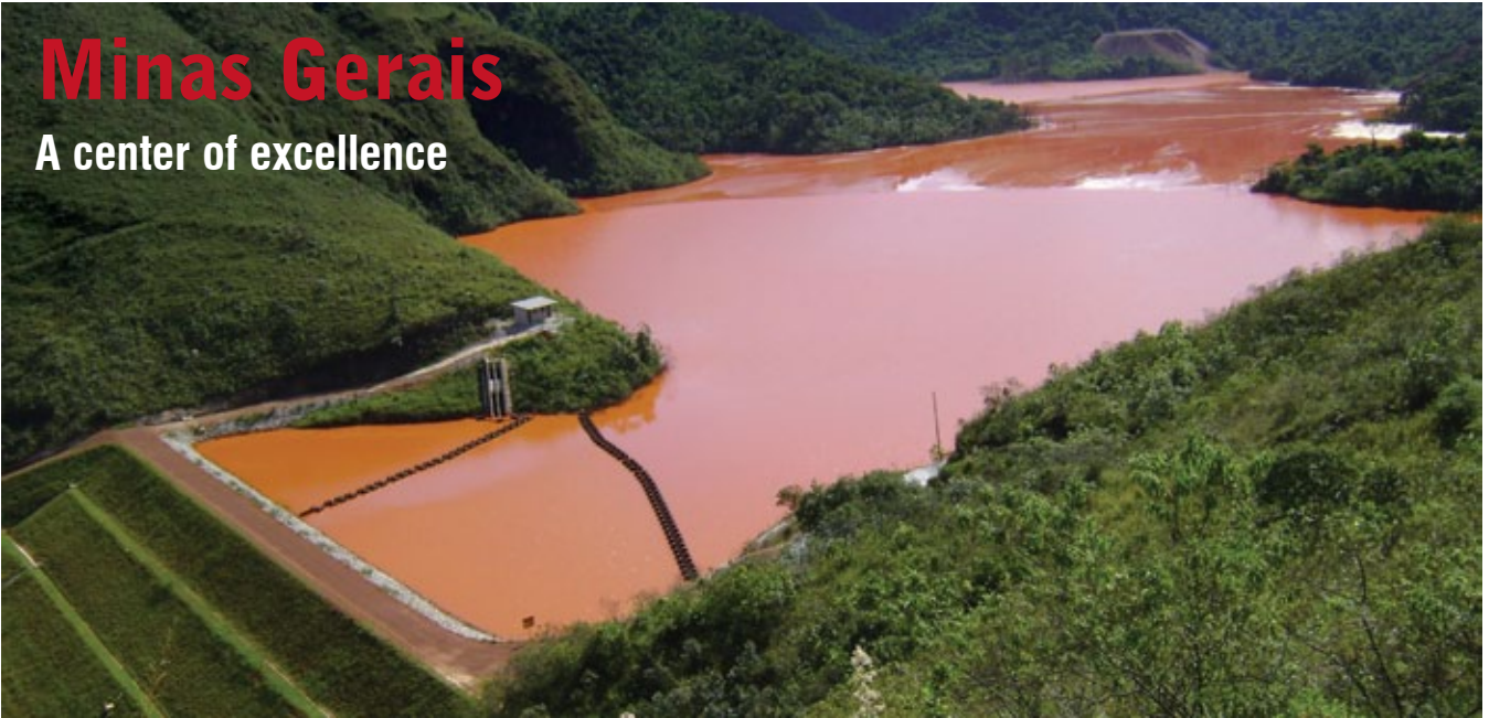
Marzagão Dam, Ouro Preto, Minas Gerais, Photo Courtesy Pimenta de Ávila Consultoria Ltda.
